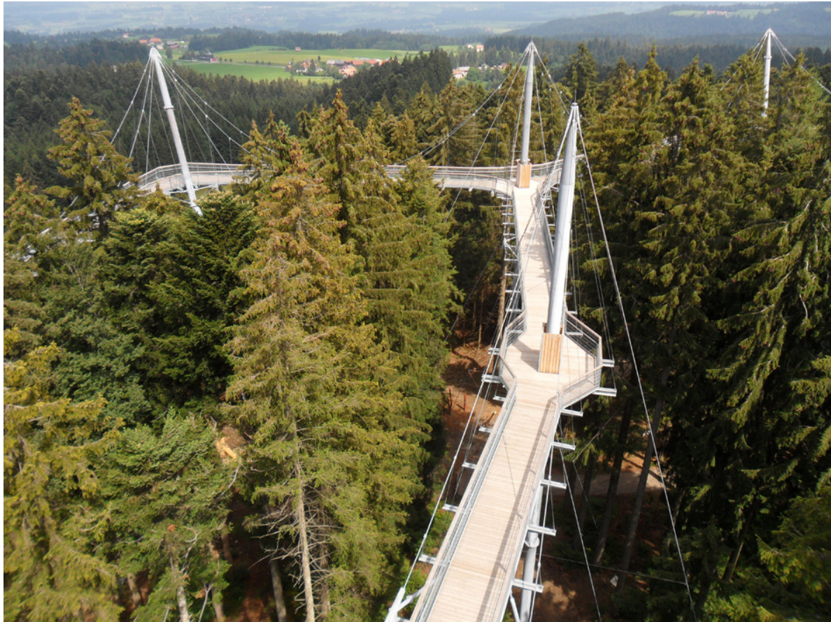
Der Skywald Allgäu geht mit einer Hängebrückenkonstruktion aus Stahl neue Wege.
